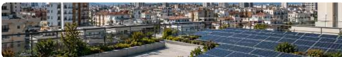
Експлуатована покрівля з фотоелектричними панелями
