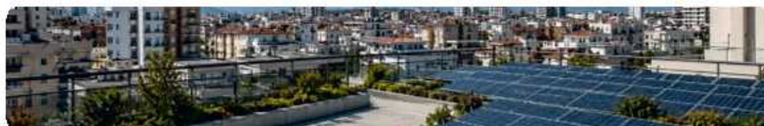
Terasă circulabilă cu panouri fotovoltaice
